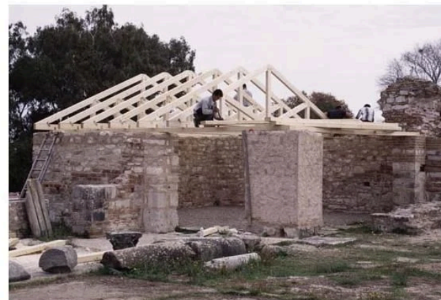
Κατασκευή στεγάστρου προστασίας ψηφιδωτού δαπέδου.
