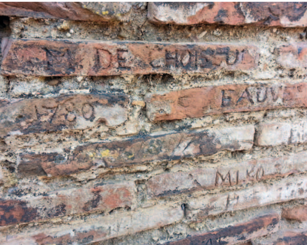
Χαράξεις χρονολογιών και ονομάτων περιηγητών του 18ου αι. σε οπτόπληνθους της σκηνής. Διακρίνεται το όνομα του Λουί-Φρανσουά-Σεμπαστιάν Φωβέλ και η χρονολογία που επισκέφτηκε το χώρο (Louis-François-Sébastien Fauvel, 1780)
