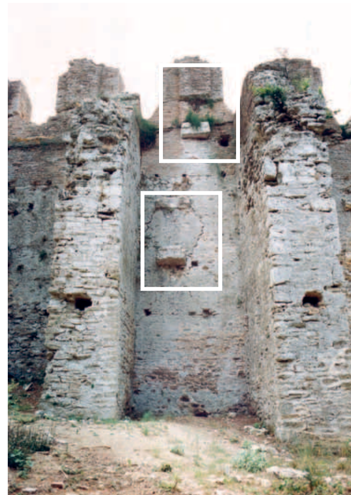
Ο περιμετρικός αναλημματικός τοίχος. Διακρίνονται οι προεξέχουσες λιθόπλινθοι στήριξης των ξύλινων στύλων του παλαιότερου (κέντρο) και του νεότερου (πάνω αριστερά) συστήματος σκιάσης (velarium)
