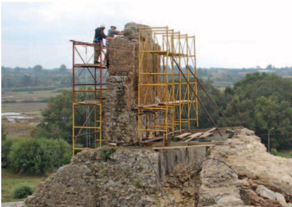
Εργασίες στερέωσης του ανατολικού τμήματος της περιμετρικής στοάς
