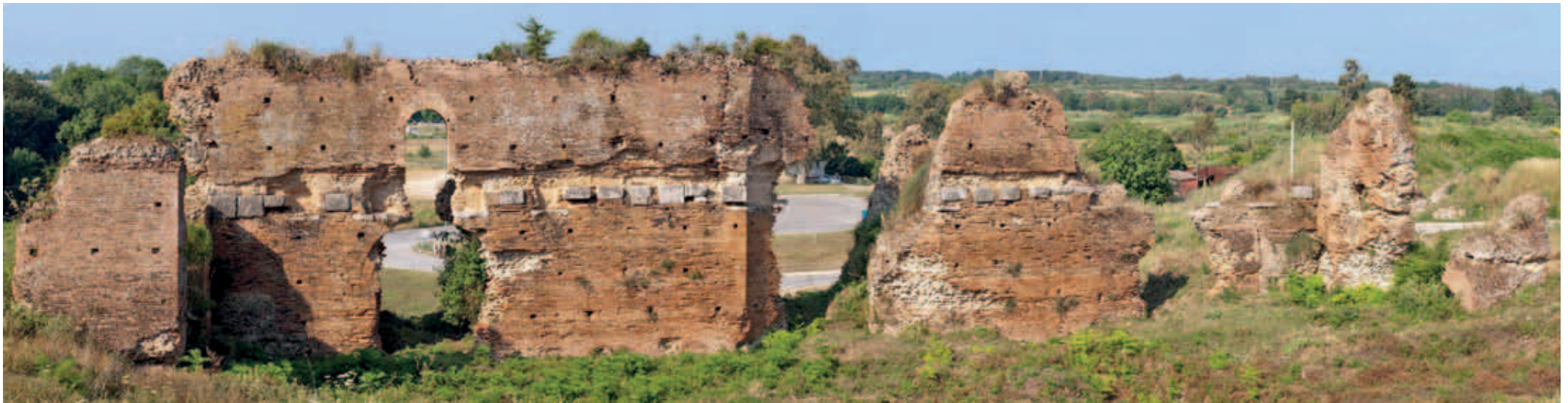
Άποψη του σκηνοικού οικοδο- μήματος από το κοίλο πριν από τις εργασίες
