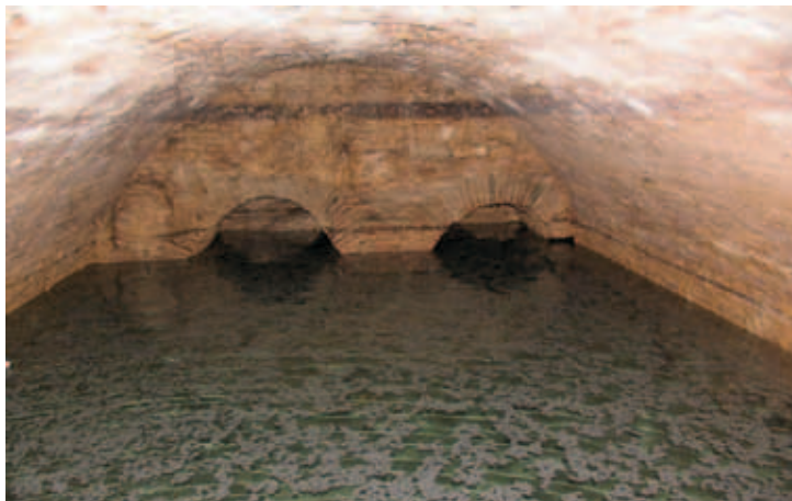
Η δεύτερη σειρά κογχών, ενσωματωμένη σήμερα σε μεταγενέστερες υπόγειες δεξαμενές
