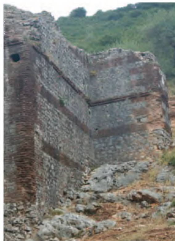
Λεπτομέρεια της βόρειας πεσσοστοιχίας του Υδραγωγείου στον Άγιο Γεώργιο
