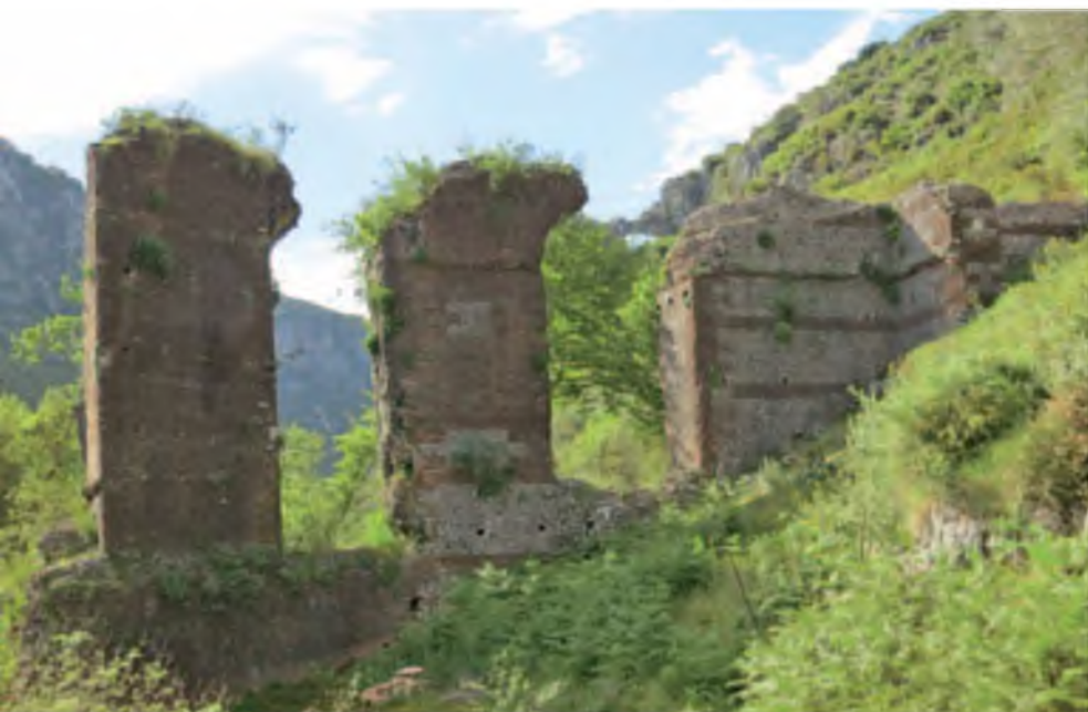
Η βόρεια πεσσοστοιχία του Υδραγωγείου της Νικόπολης στον Άγιο Γεώργιο. Άποψη από ανατολικά
