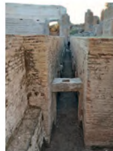
Η αύλακα του μηχανισμού της αυλαίας
